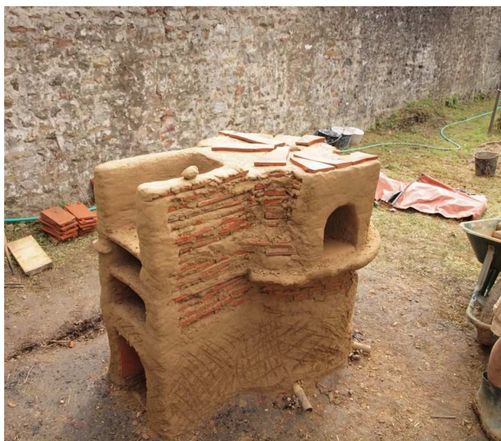
Construction du fou.
