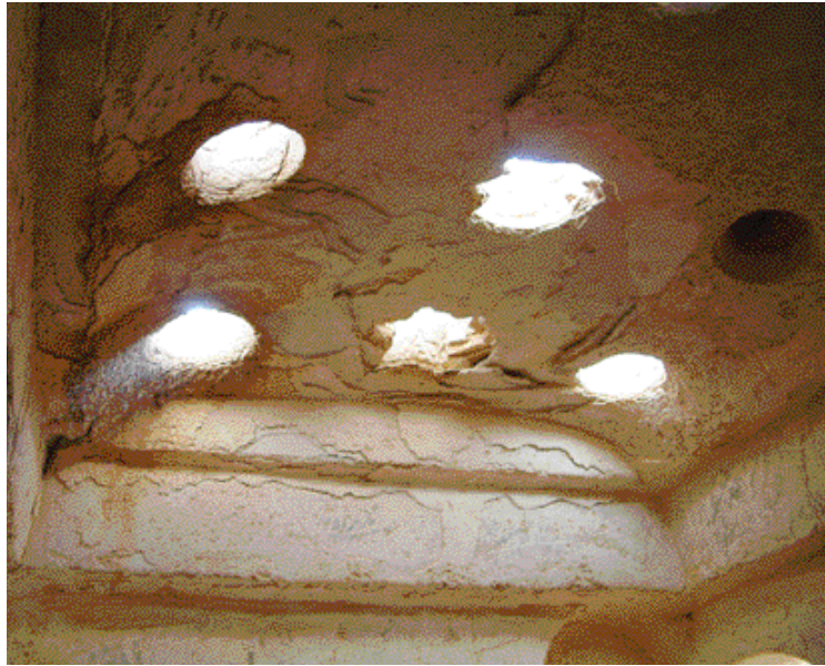
167 Plafond de la salle chaude.
