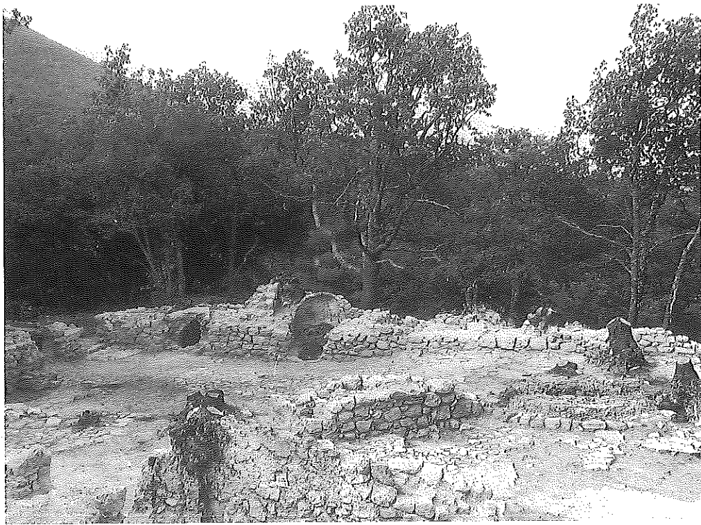
Fig. 3 : La halle vue depuis la chambre à pots ; à droite le four de fusion, au fond les fours de recuit 2 et 3 et à gauche le four 4.
